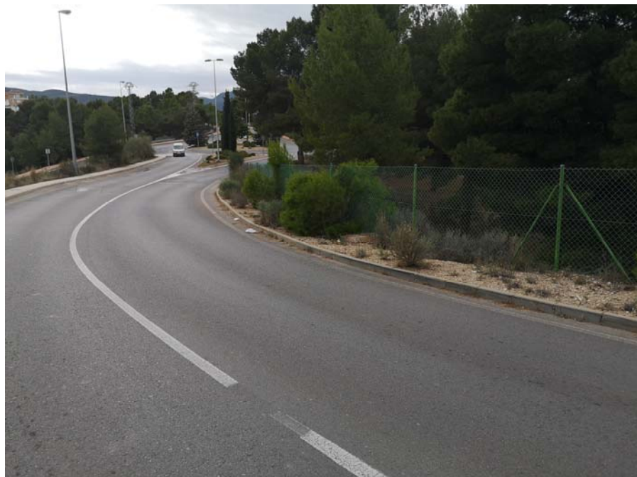
Fot.7, 8- Vial que recoge gran caudal de agua en Residencial.
