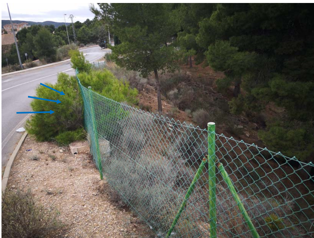
Fot. 9- Localización de nueva canal para mejora de la esorrentía del agua
