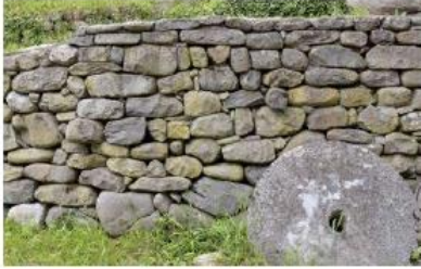
Muros de Piedra Seca
